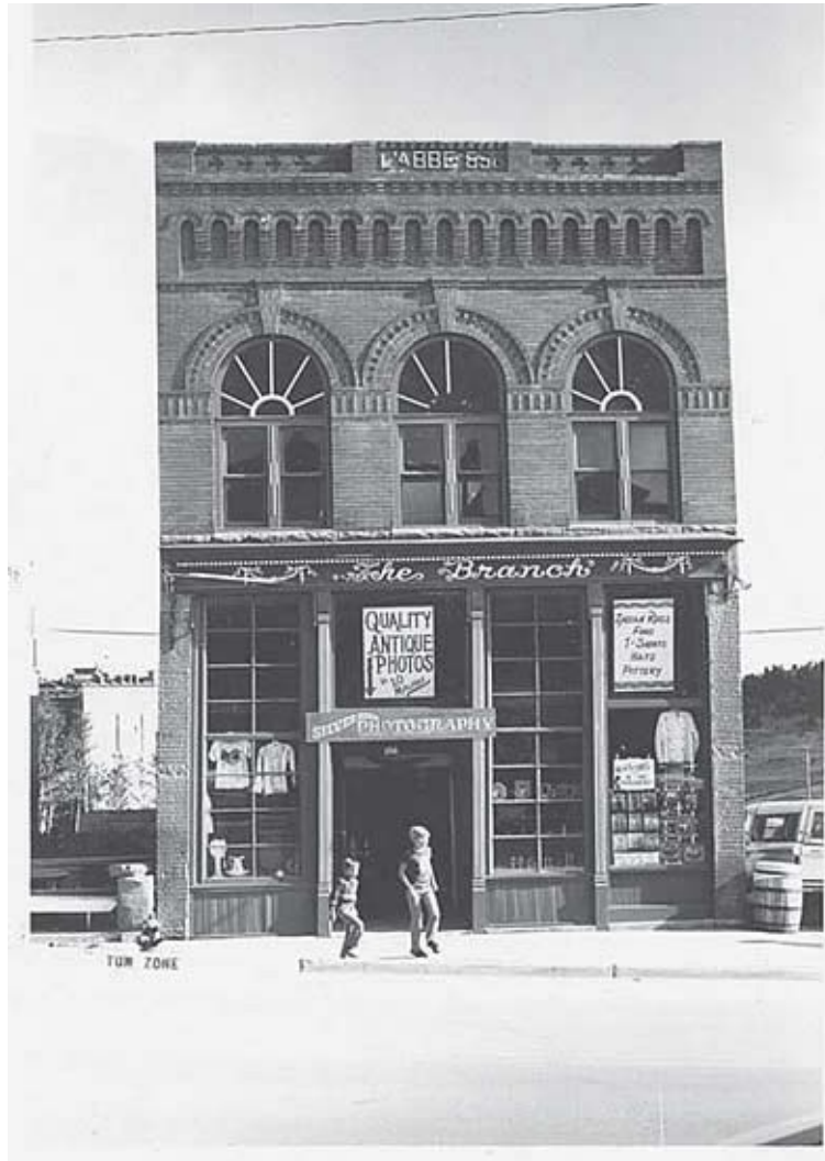
Cripple Creek. (Fotografía del autor.)
